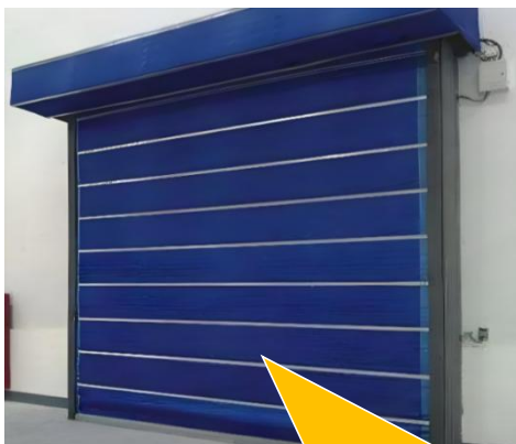
除兼做货梯外的消防电梯前室采用防火卷帘门作为防火分隔
