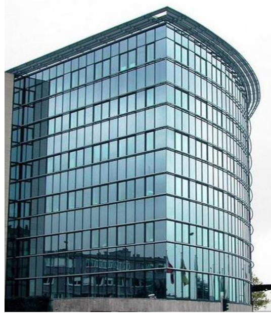
燃烧性能为 A 级的玻璃幕墙
