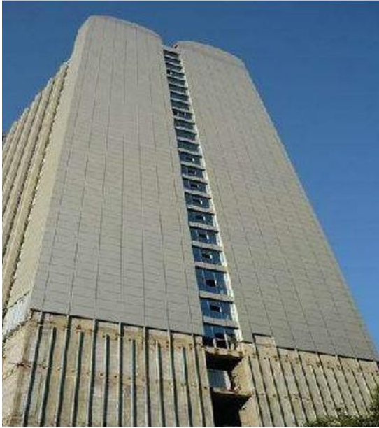
燃烧性能为 A 级的石材幕墙
