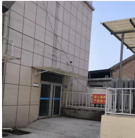
室外液氧罐与办公室等距离不小于 7.5\text{m} , 罐体外壁至建筑物的距
