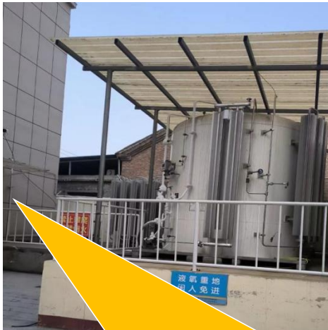
室外液氧罐与办公室等距离不小于 7.5\text{m} , 罐体外壁至建筑物的距
