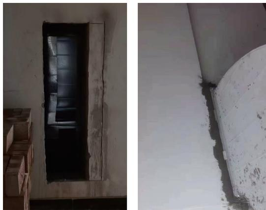
图 4-5 开洞作业与洞口封堵
