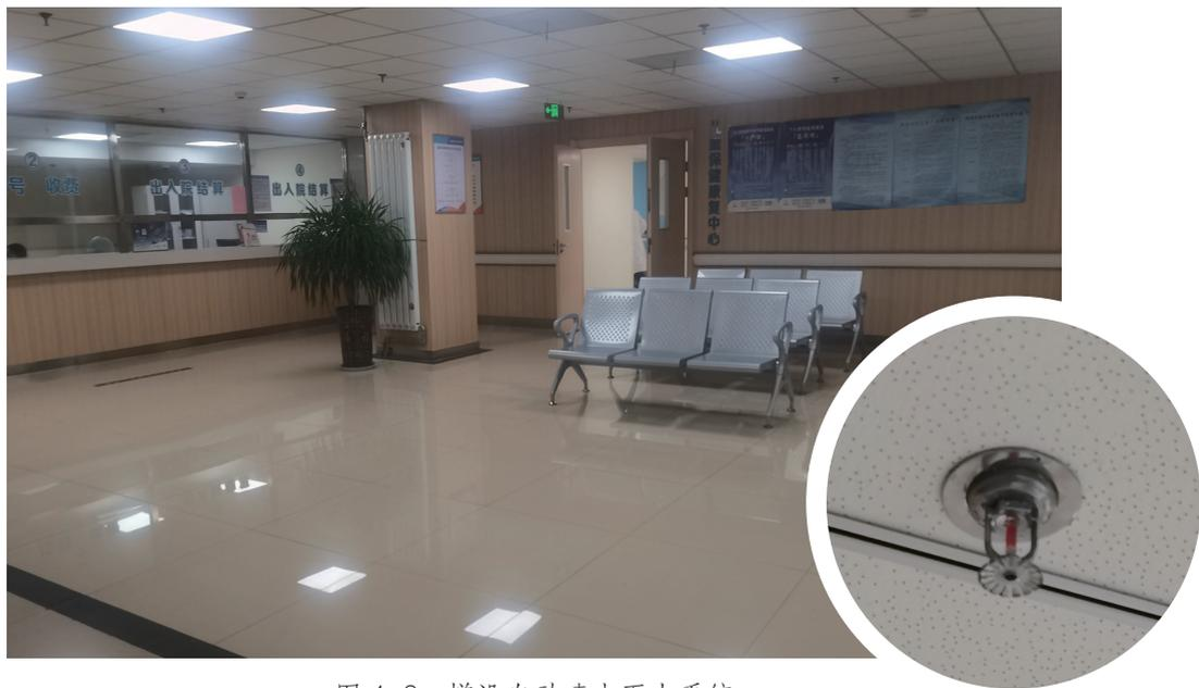
图 4-2 增设自动喷水灭火系统
