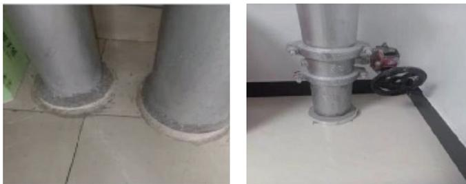
图 1-18 改造完防火封堵照片
