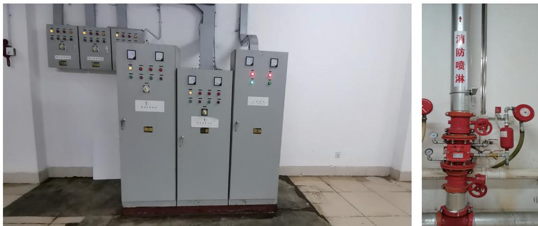
图 4-3 消防水泵房自动喷水灭火系统组件
