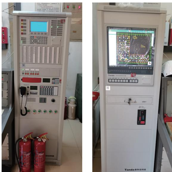
图 4-7 火灾自动报警系统信号控制
