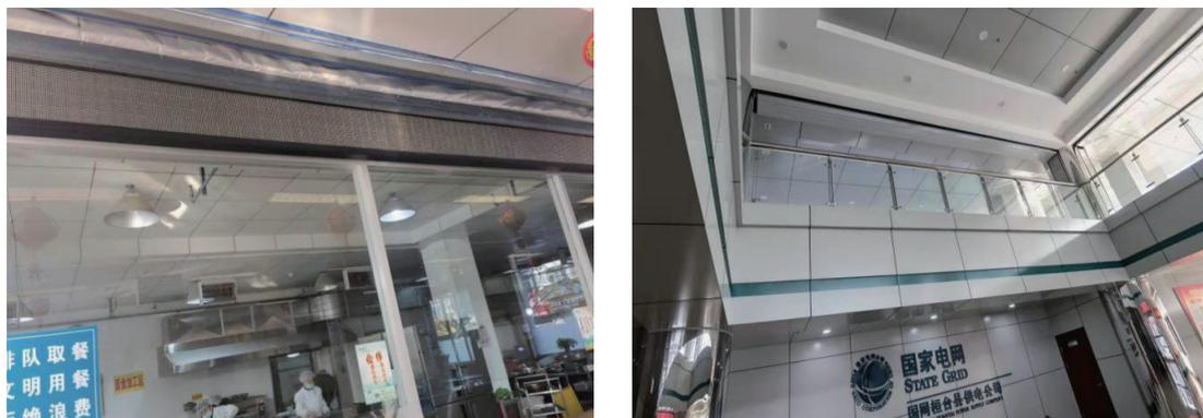
图 1-17 改造完防火卷帘照片
