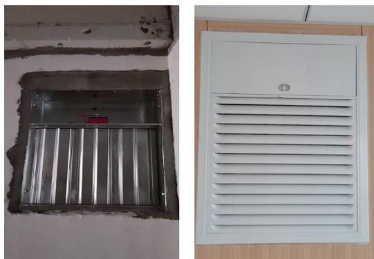
图 4-4 防排烟系统风口安装设置
